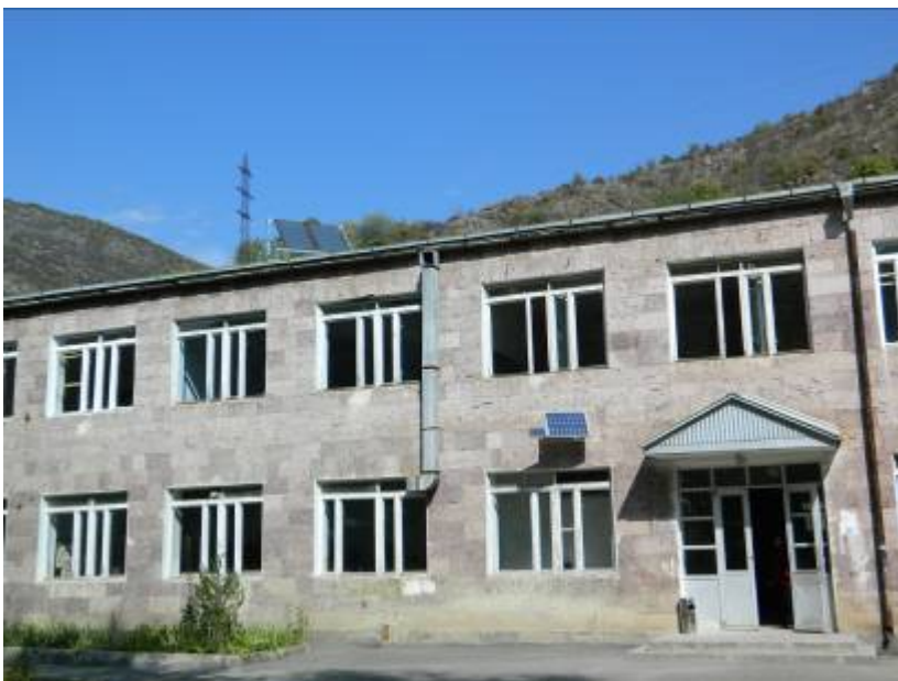
Նկ. 4.3 Ուսումնական մասնաշենքի արևային էներգիայի վրա հիմնված տաք ջրի մատակարարման համակարգը և ֆոտոէլեկտրական համակարգը
