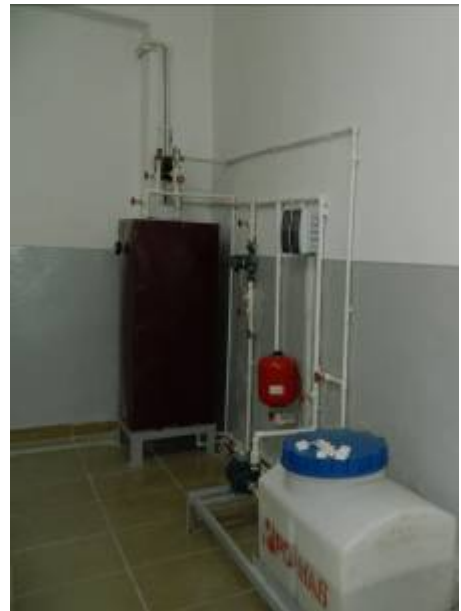
Նկ. 4.3 Ուսումնական մասնաշենքի արևային էներգիայի վրա հիմնված տաք ջրի մատակարարման համակարգը և ֆոտոէլեկտրական համակարգը
